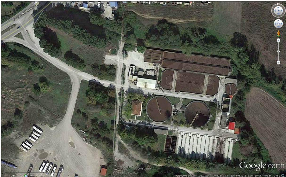
Εικόνα 1. Άποψη εγκατάστασης επεξεργασίας λυμάτων πόλης Τρικάλων
